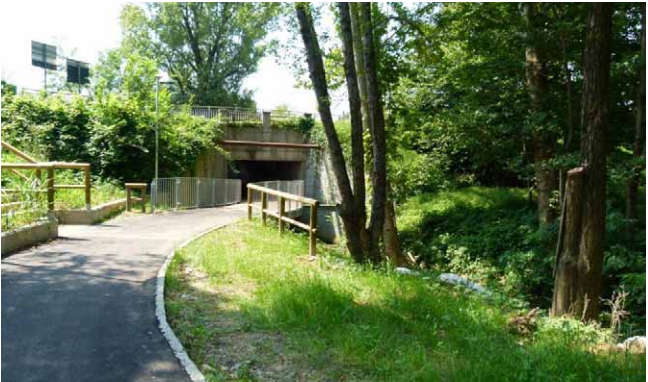
Le passerella ciclopedonale che, attraverso il viadotto del Grandone, permette di superare la S.P. 166 Via Pedrinelli.
